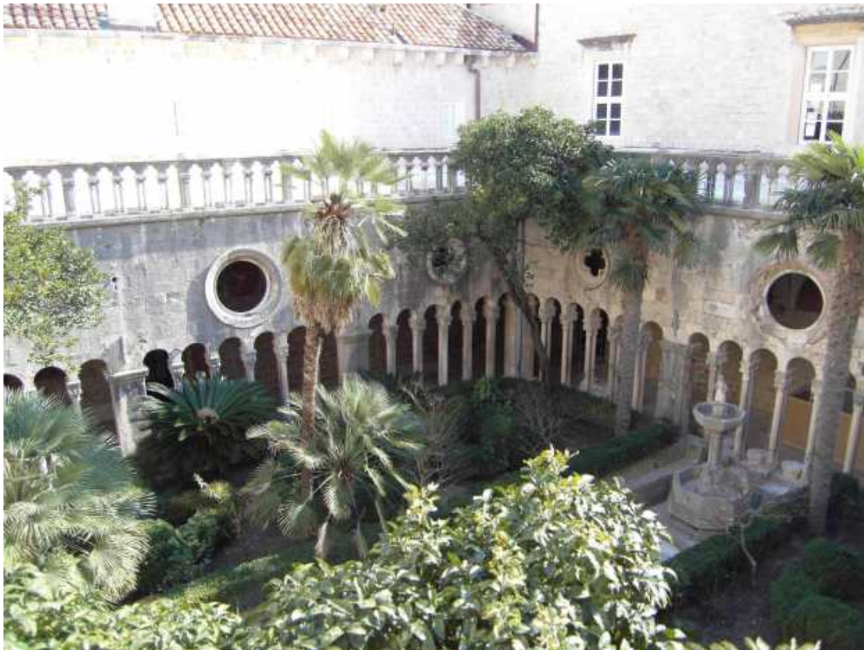
Pogled na jugoistok prije obnove
